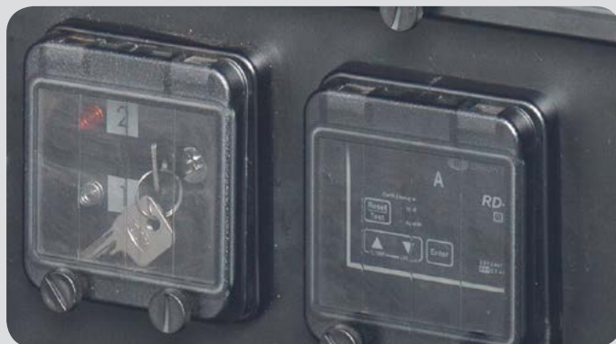
FI-Schutzschalter, abschaltbar
